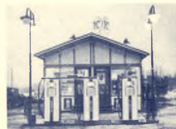
Stationsbyggnaden ligger med bekväma infarter alldeles intill landsvägen.
